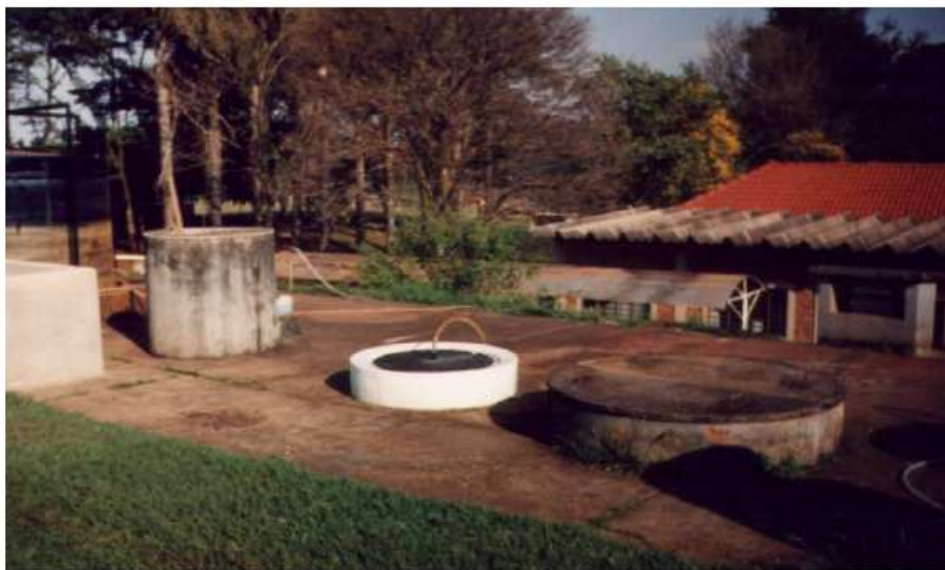
Figura 5: Biodigestor modelo chinês Fonte: Castanho (2008)
