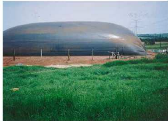
Figura 4: Biodigestor modelo canadense Fonte: Castanho(2008)
